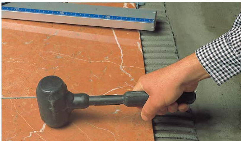
Tapoter les pièces pour s'assurer de leur bonne fixation.
